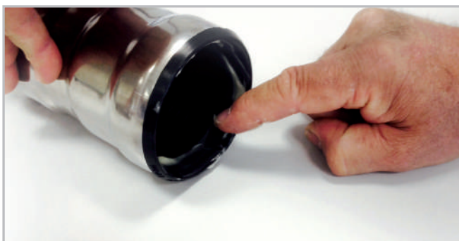
Figura 6 - Lubrificazione zona interna guarnizione
